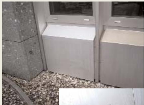
▲ Eloxiertes Aluminiumblech, das mit alkalischem Reiniger behandelt wurde ▶
